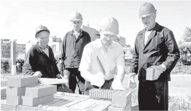
Закладка первых кирпичей здания УФО-очистки на очистных сооружениях водопровода
