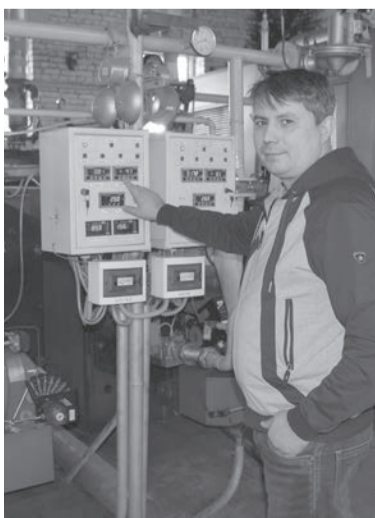
Начальник участка котельных Данил Хасанов
