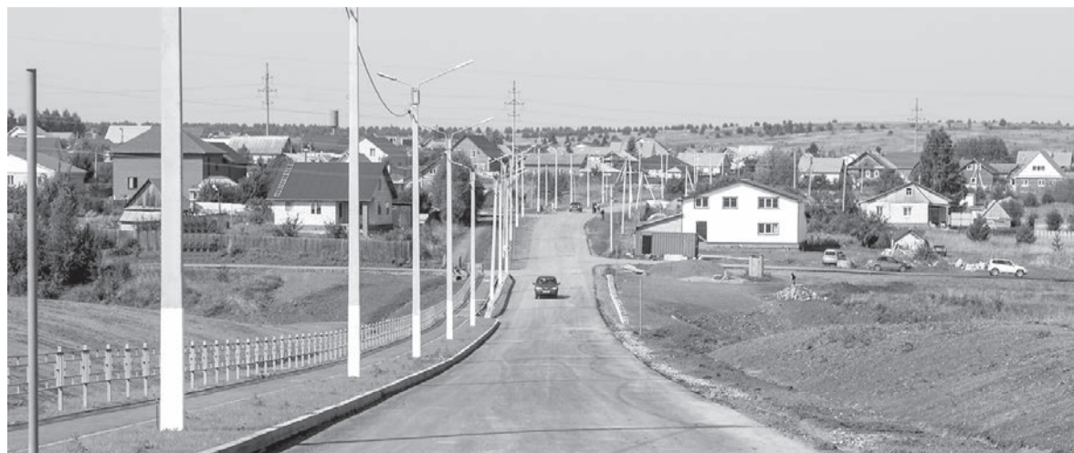
Завершается строительство дороги на поселок КХП
