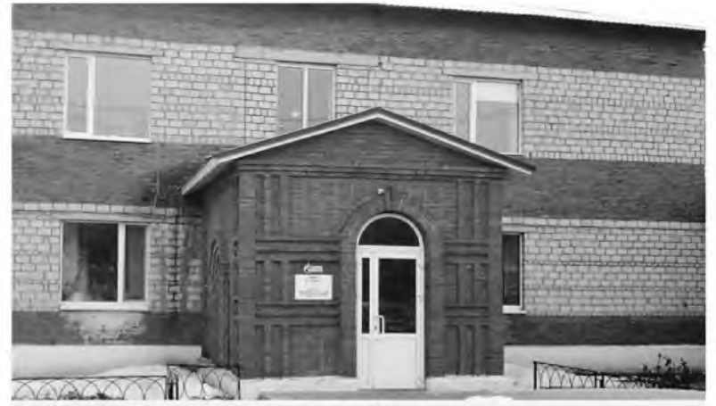
Современное здание филиала в г. Сарапуле
