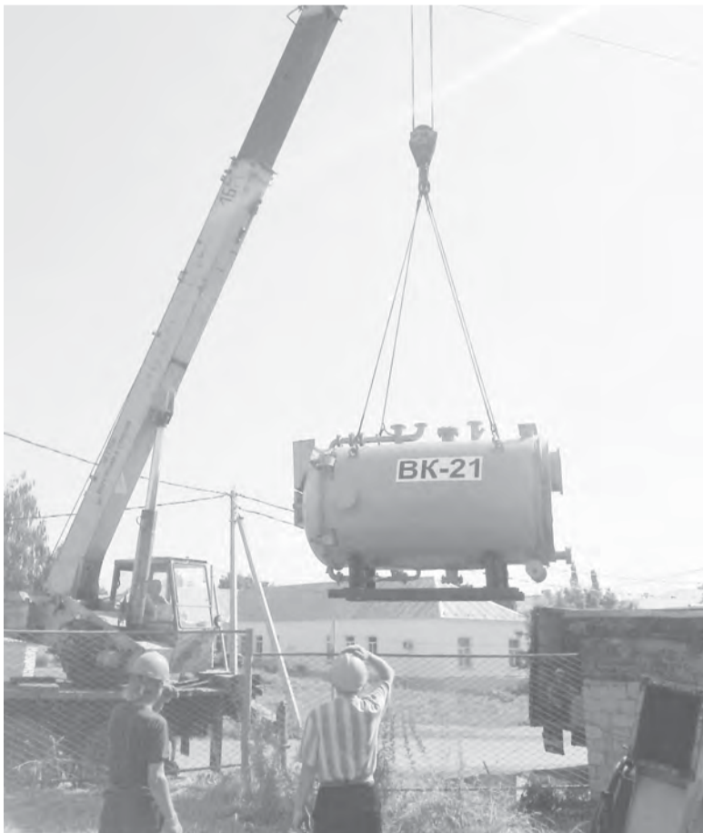
Установка водогрейного котла BK-21 в котельную с. Сигаево
