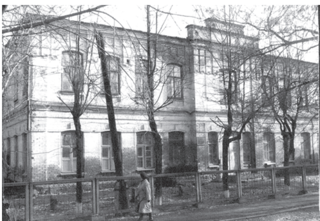
Ремесленная школа (район Поворота, позднее здесь располагалась детская больница, ныне проводится реконструкция здания)
