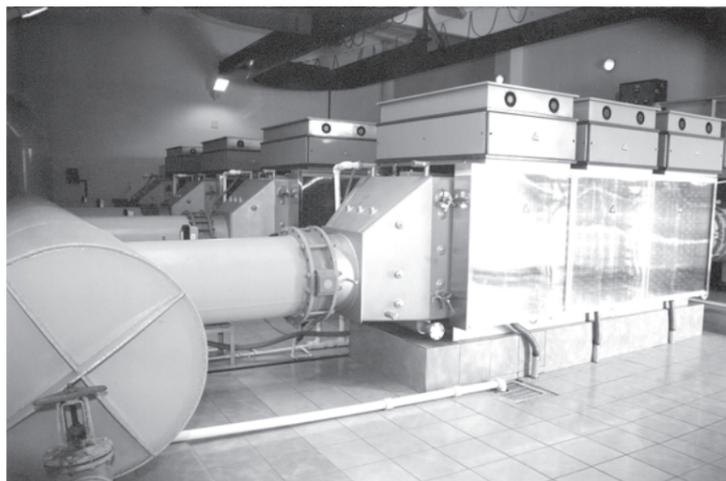
Оборудование станции ультрафиолетового обеззараживания стоков на очистных сооружениях канализации муниципального унитарного предприятия г. Сарапупа «Сарапупский водоканал» введено в эксплуатацию 14 июля 2005 года
