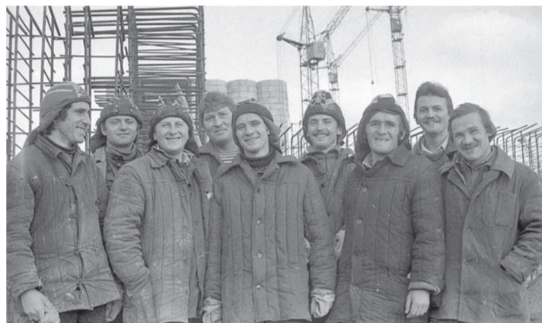
Комплексная комсомольско-молодежная бригада Сергея Кочурова на строительстве Сарапұльского комбината хлебопродуктов
