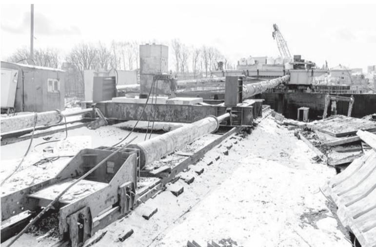
В последние дни марта мостостроители производили укладку бетона второй опоры и надвижку пролетного строения.
