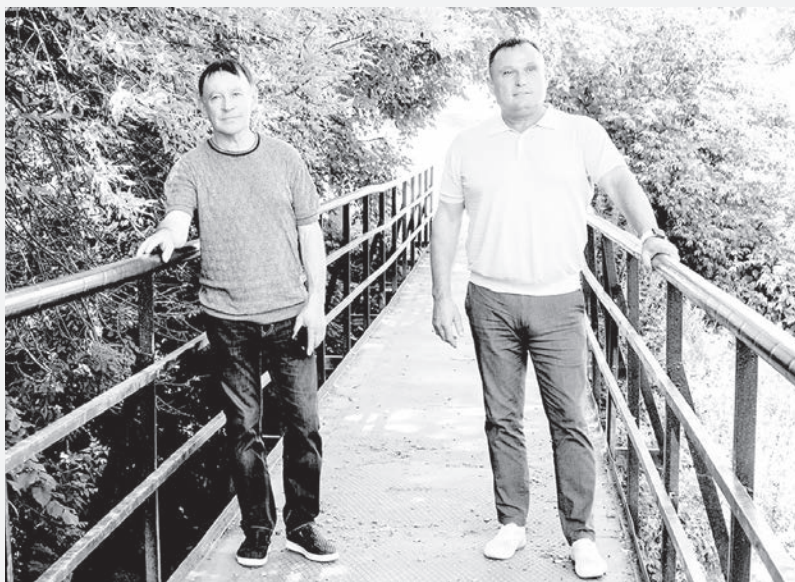
По просьбам жителей ул. Сухой Лог Анатолий Павлов и Сергей Шадрин оказали помощь в ремонте пешеходного моста через улицу, защебенили подходы к мосту, завезли щебень для устройства пешеходной дорожки
