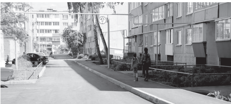
Двор дома № 20 по ул. Озерной после реконструкции
