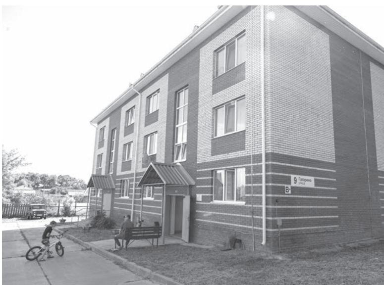
Дом по адресу: ул. Гагарина, 9 построен в рамках федеральной программы «Переселение граждан из аварийного и ветхого жилья»
