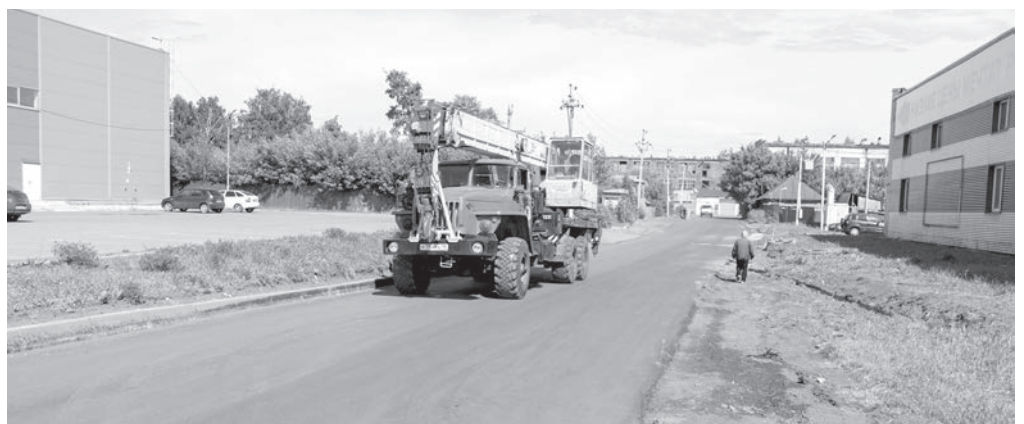
Ремонт проезжей части в переулке 3-й Дубровский
