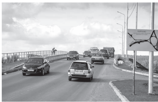
Завершена реконструкция путепровода через железную дорогу по ул. Гончарова
