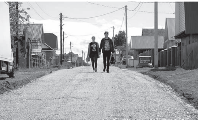
Новая дорога по 2-му Зеленому проезду
