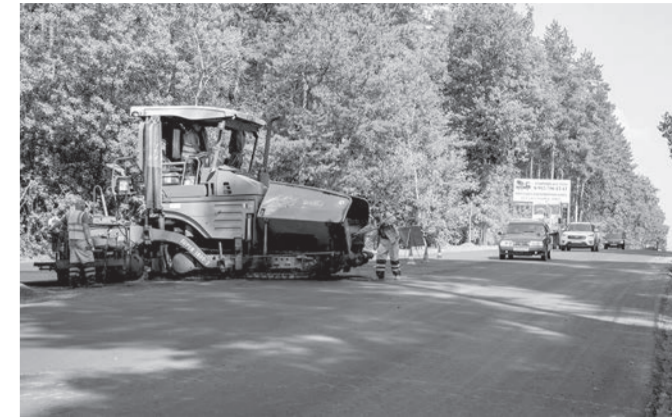
Ремонт дороги по Лесному проспекту
