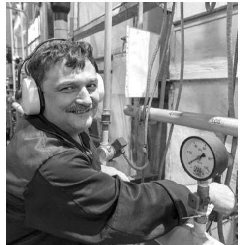
Более 25 лет трудится в отрасли энергетики оператор котельной по ул. Еф. Колчина, 36 ООО «Сарапултеплоэнерго» Олег Галанов
