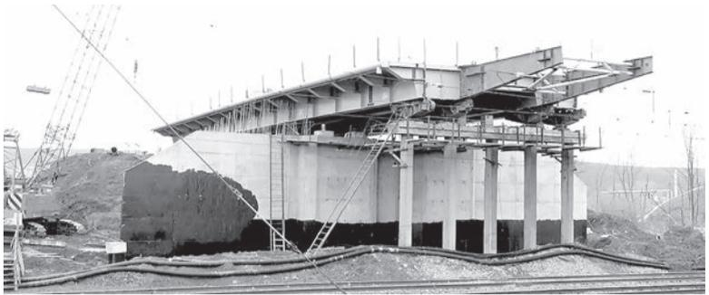
Рабочие подрядной организации приступили к надвигке пролетного строения на опоры. Процесс этот длителен и трудоемок: пролет надвигается на опоры домкратами со скоростью 2-2,5 метра в час.
