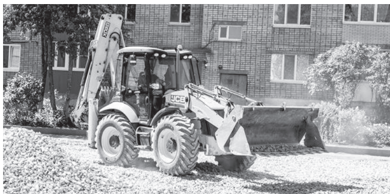
Работы проводятся во дворе дома № 8 по ул. Ленина по программе «Формирование комфортной городской среды»
