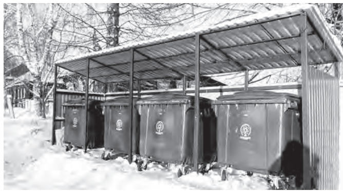
Новая контейнерная площадка для ТКО по ул. Седельникова
