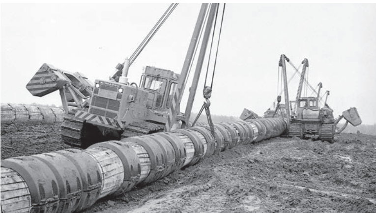
Прокладка первой «нитки» газопровода Уренгой-Помары-Ужгород
