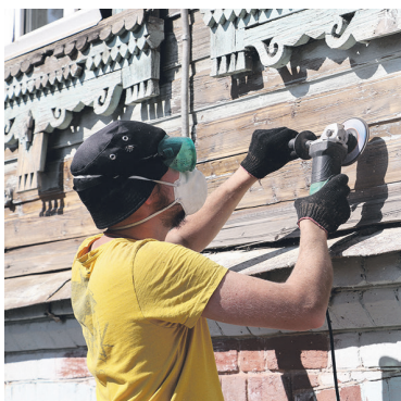
Начало работ на доме № 32 по ул. Советской
