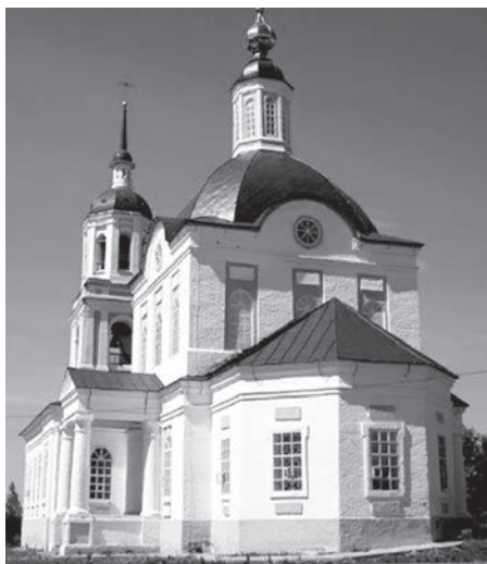
Церковь в с. Мостовое, восстановление начато в 2008 году
