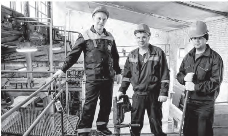
Реконструкция котельной по ул. Раскольников, 146 «д»: демонтаж котла проводят слесари Виктор Котов , Павел Шадрин и Раиль Салахетдинов (слева направо)
