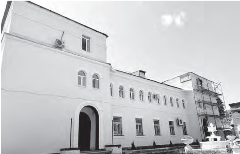
Обновленный фасад здания
