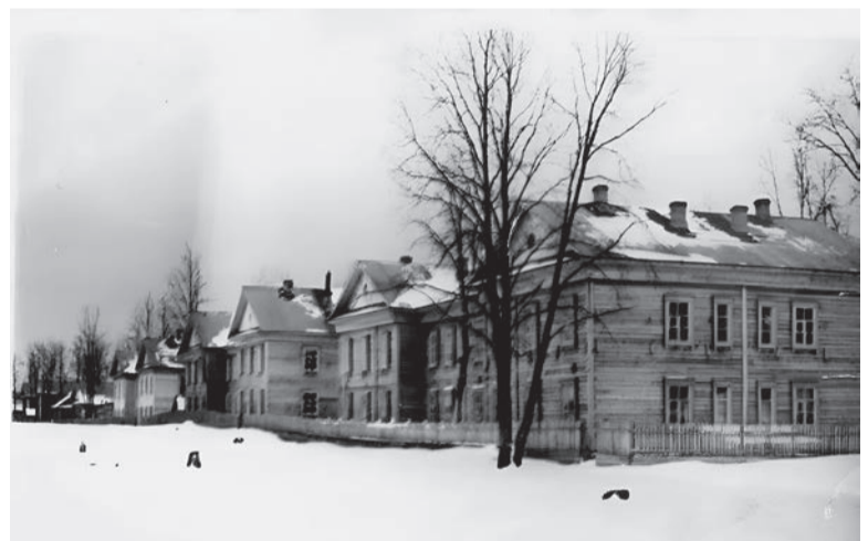
12-квартирные дома по улице Кирова, 1950-е годы
