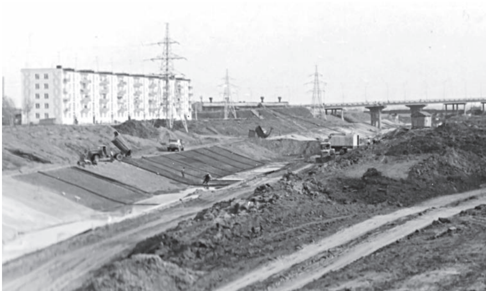
Строительство обводного канала, 1985 год.
