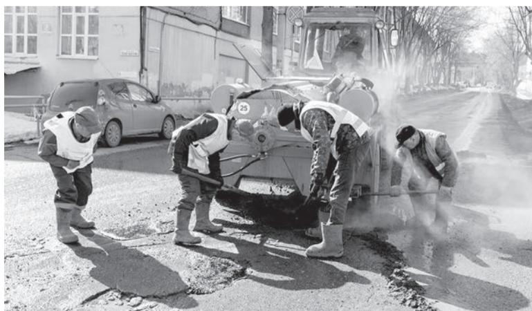
Процесс укладки асфальтобетонной смеси в образовавшиеся в период зимы и весны ямы на ул. Гагарина
