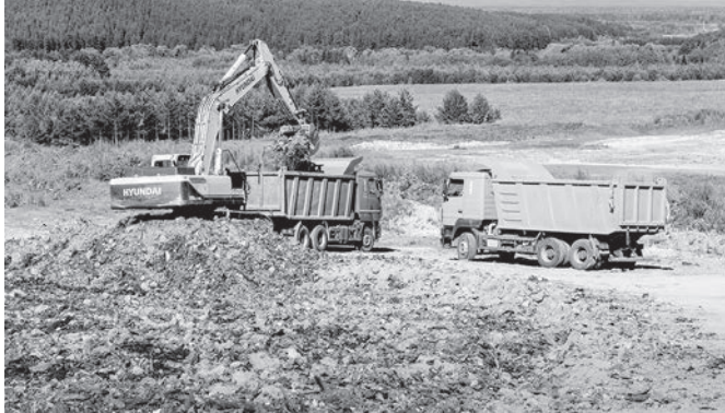
В прошлом году завершена рекультивация полигона ТБО по старому Ижевскому тракту
