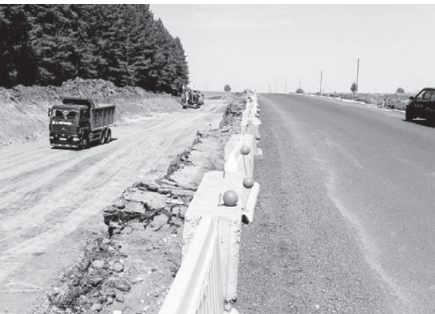
Ремонт дорог в селе Тарасово
