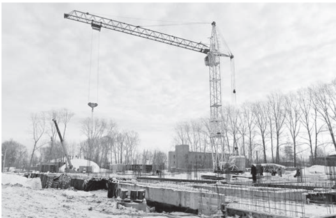
Строительство новой поликлиники в микрорайоне железнодорожного вокзала
