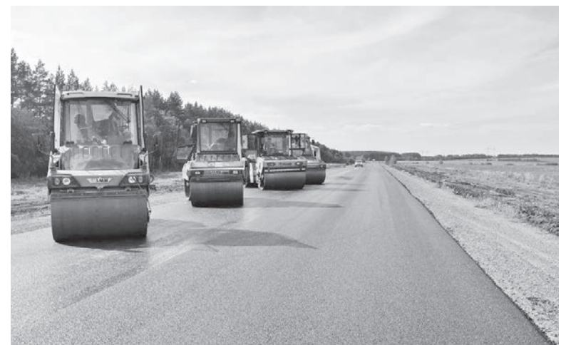
Ремонтные работы на трассе «Костино-Камбарка»
