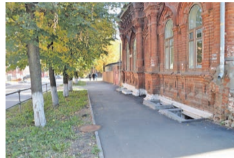
Новые тротуары по ул. Горького
