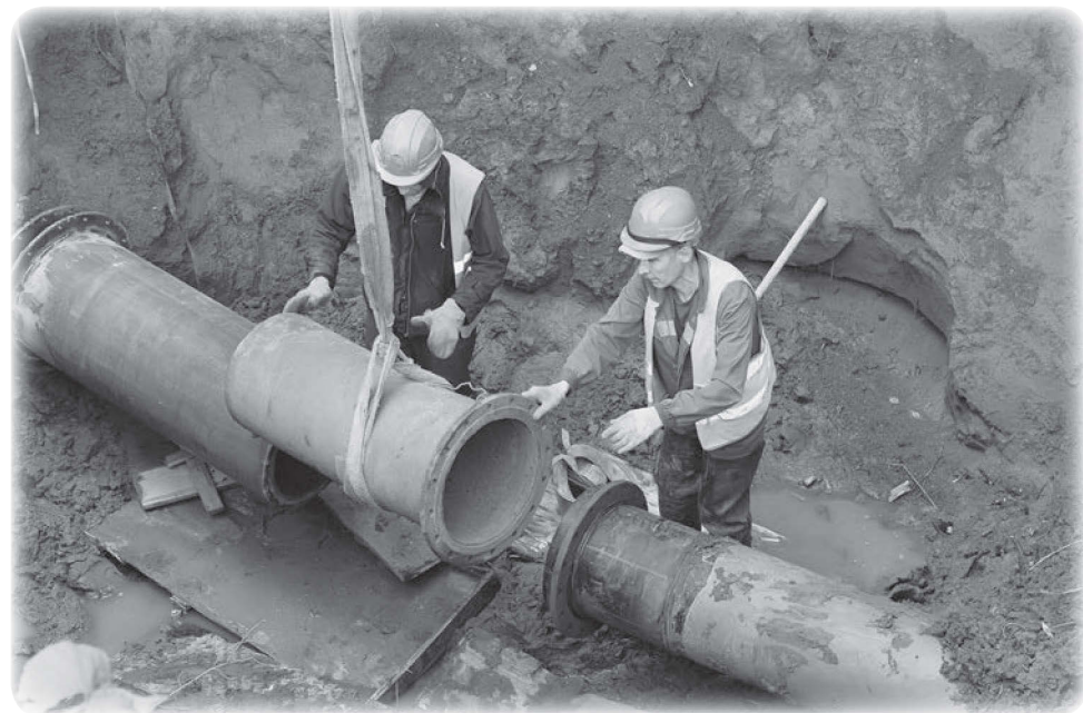
Ремонт водопровода диаметром 400 мм
