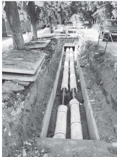
Ремонт теплотрассы по ул. Горького
