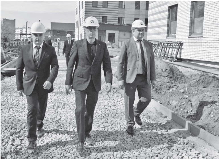
На строительной площадке новой поликлиники
