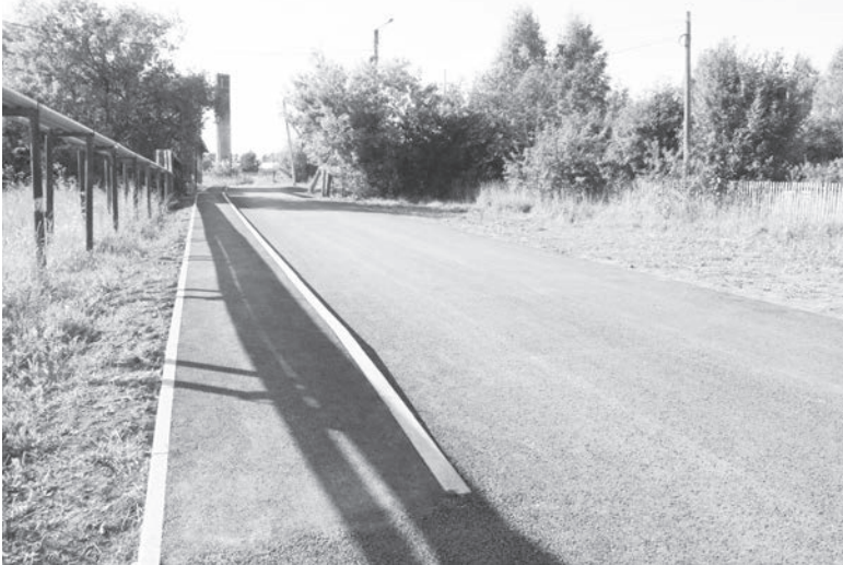
Отремонтированные дороги в населенных пунктах Сарапульского района
